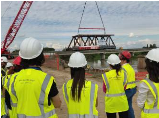
Operai al lavoro Nel capitolo Infrastrutture 13 milioni da spendere
